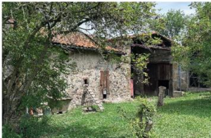
BATIMENT 1.c Surface totale : 165 m 2
